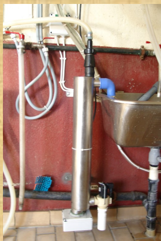
Tanknedløp med varmelement
